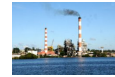
Termoeléctrica "Carlos Manuel de Céspedes" de Cienfuegos. Foto: Juan Carlos/ 3 de Septiembre.
